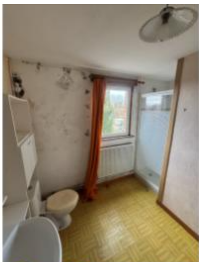
R+1 Logement 2 // Future Chambre 1
