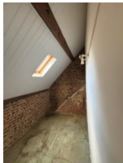
Palier existant / Future Chambre 2
