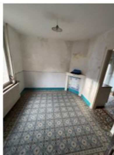
Future Salle de douche et WC
