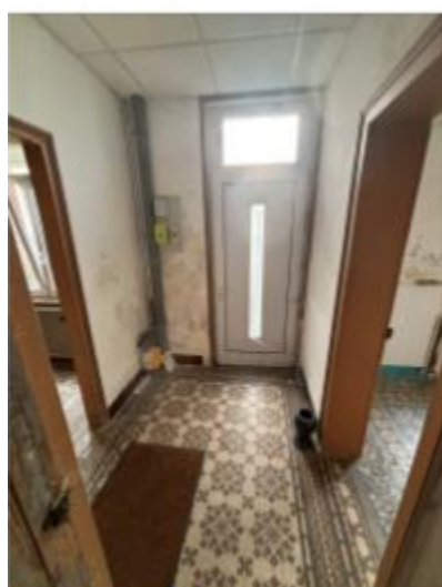
RDC Logement 2 // Entrée
