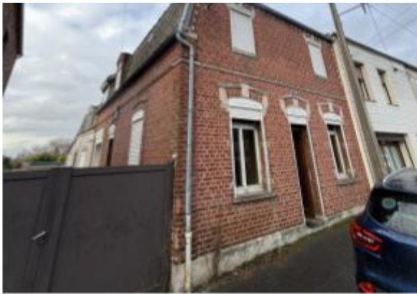
Photo du bâtiment existant
