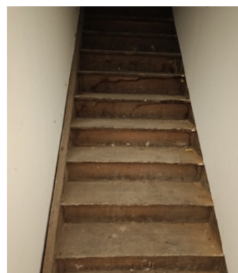
Escalier d'accès au R + 1 entièrement sécurisé
