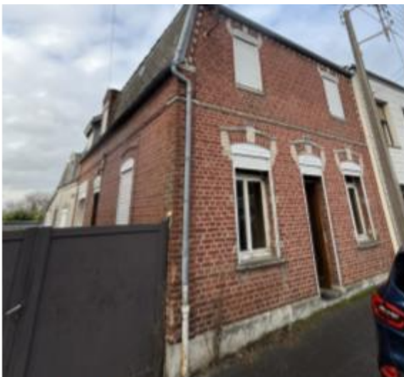
Façade de l'existant sur rue
