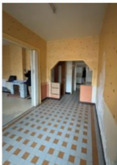
RDC Logement 1 // Séjour
