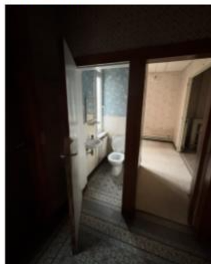
RDC Logement 1 // WC
