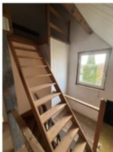
R+1 Logement 2 // Escalier existant
